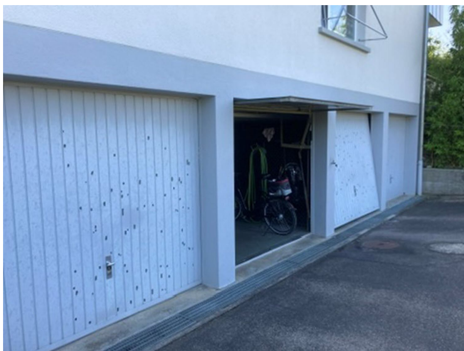
Kipptore vor Renovation
