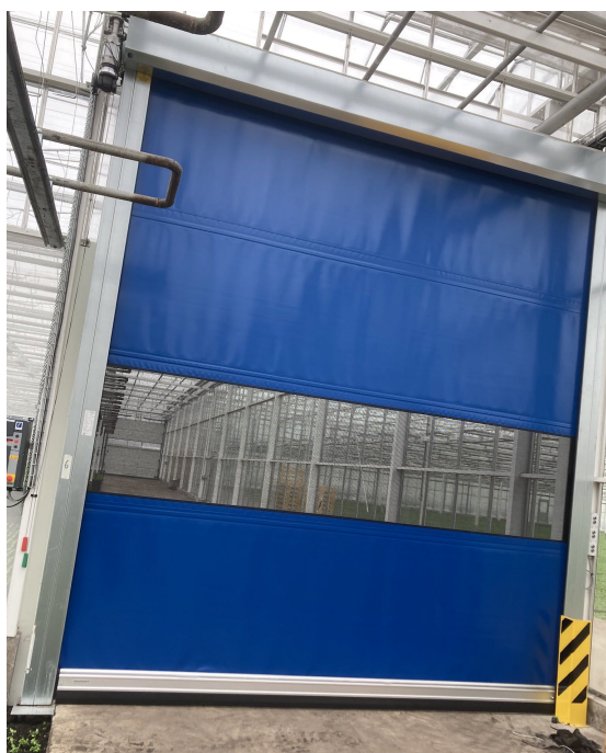
Schnellauftor V 5030 SEL in Treibhaus mit Insektenschutz im Sichtfeld
