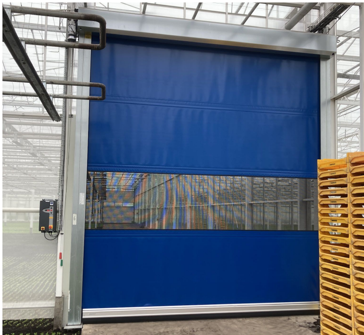
Schnellauftor V 5030 SEL in Treibhaus mit Insektenschutz im Sichtfeld
